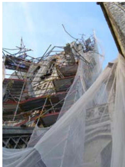
Figuur 51: Gevolg van slechte verankering
