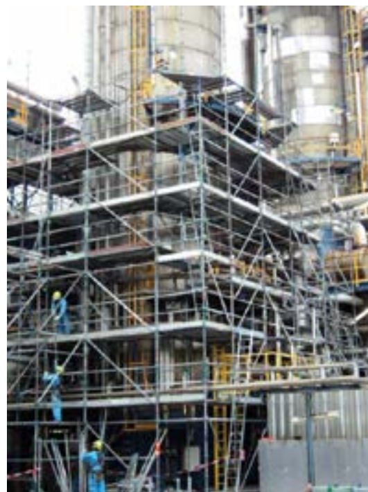
Figuur 35: Geïntegreerde ladder
