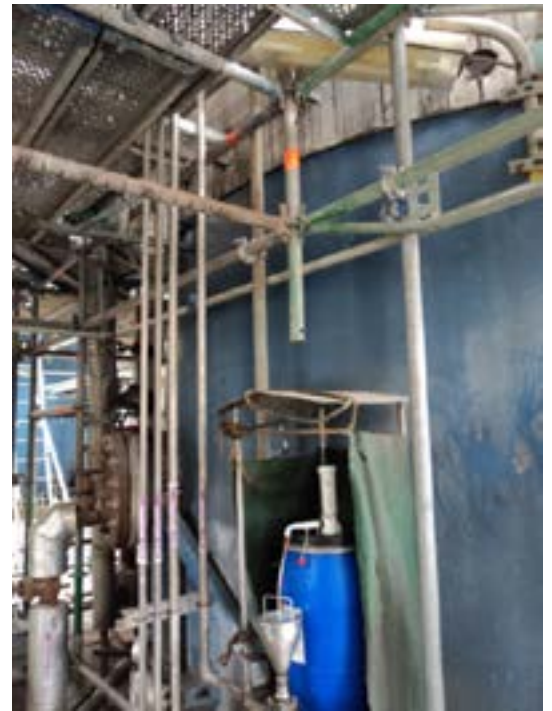
Figuur 23: Verspringing staanderinplanting
