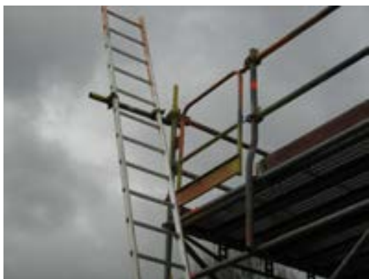
Figuur 37: Toegang via externe ladder & poortje
