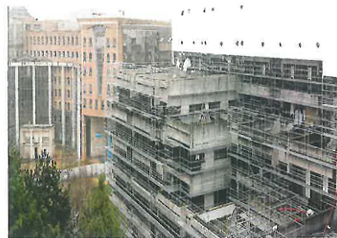
Les ouvriers interviennent par zone pour enchaîner : désamiantage, démolition puis reconstruction et ainsi agir rapidement. Jonathan ALEXANDRE
