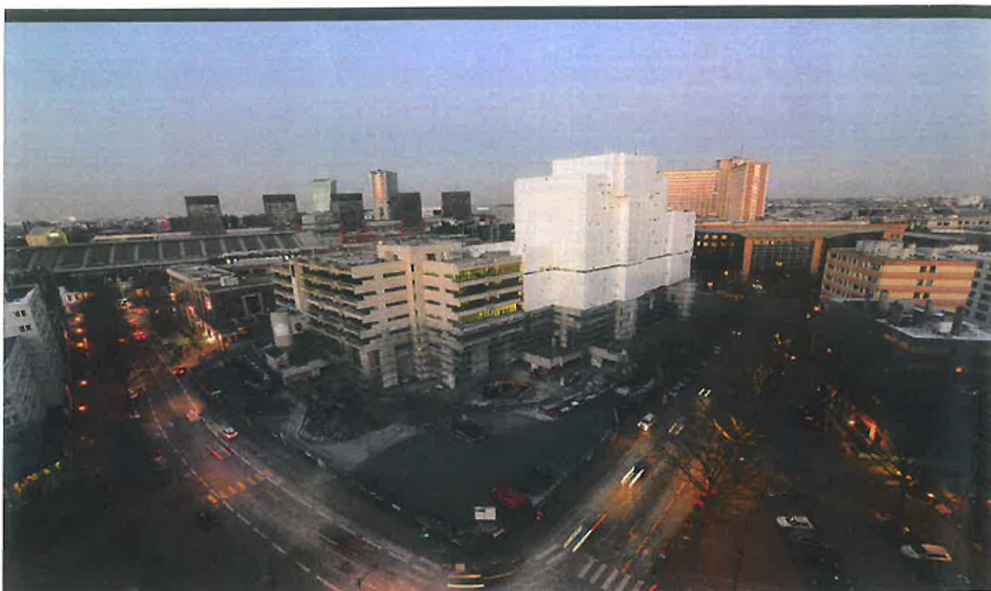
Le Forum du département du Nord va être démolit et reconstruit. Pour opérer la phase de désamiantage et démolition, les entreprises du groupement Renard et Snaec ont dû encapsuler le chantier. Crédits photos : DEVISUBOX et Groupement ADIM/DUVAL
